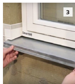
Prøvemontér sålbænken i den prøvemonterede Sto Smartsill.
