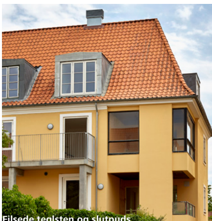
Filsede teglsten og slutpuds
