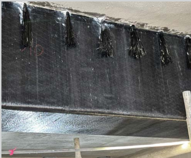
Kulfiberankre i combination med en kulfiberdug styrker den eksisterende beton og forlænger levetiden
